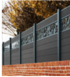
Pose sur muret
