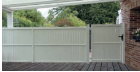
Pose en claustra de séparation
